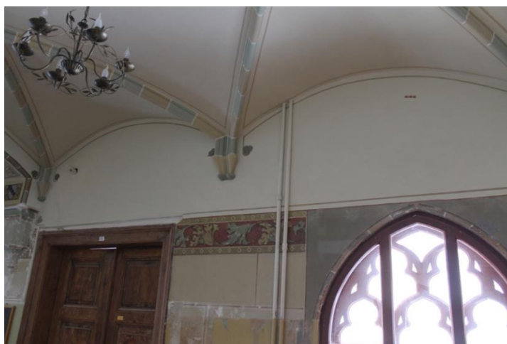
22. attēls. Jaunās pils pirmā stāva galvenās kāpņu telpā veikta sienu gleznojumu daļēja atsegšana un konservācija
