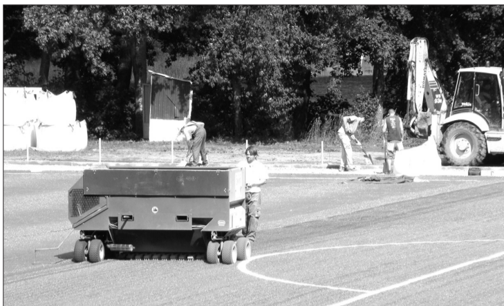
Stadionā ieklātais mākslīgās zāles segums tiek tehnoloģiski apstrādāts, lai tas būtu lietošanas kārtībā
