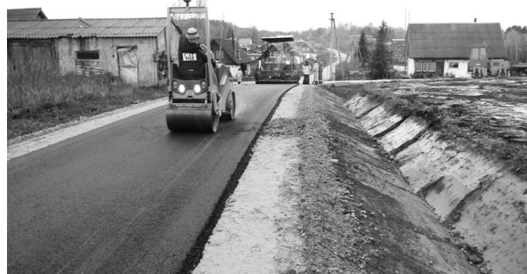
Asfalta segums uzklāts ceļam Veclaicenes pagastā...
