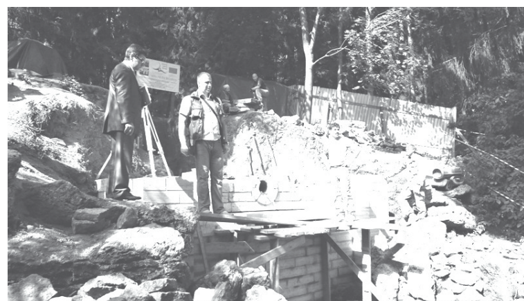
Notiek Lielās kaskādes restaurācija
