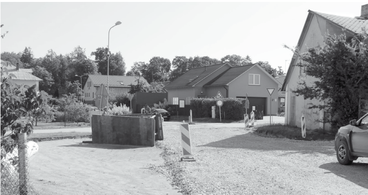
Siguldas ielas krustojumā izbūvēs arī šķirojamo atkritumu novietnes laukumu Evitas Aplokas foto
