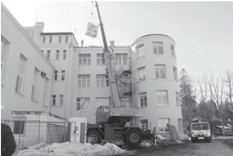
Ventilācijas iekārtu iecelšana notika caur atvērumu ēkas jumtā Evitas Aplokas foto
