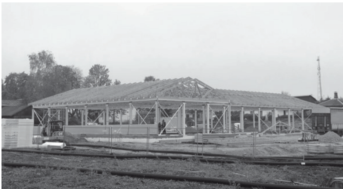
Biznesa stacijas ēkas būvdarbi oktobrī jau krietni pārvirzījušies uz priekšu
