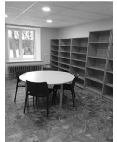
Mārkalnē remonta veikta bibliotēkas telpā
