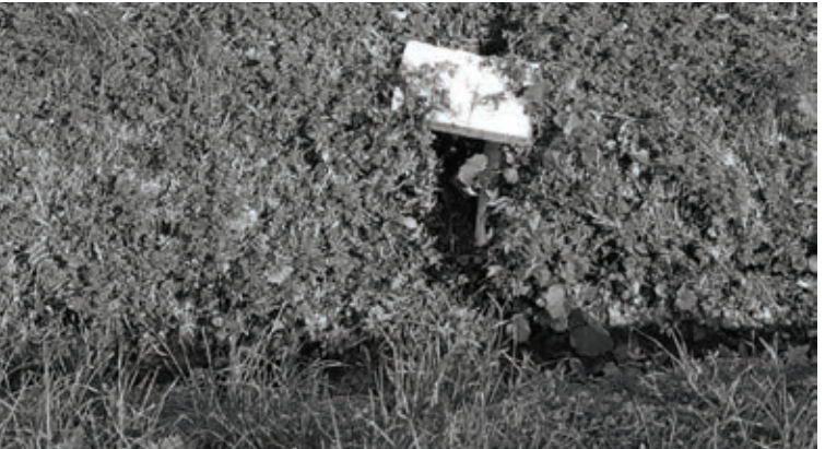
Konstatēts, ka no privātmājas teritorijas pa cauruli pašvaldības piekritīgās zemes grāvī nonāk kanalizācijas ūdens. Par kanalizācijas ūdens novadīšanu jākonsultējas ar SIA “Rūpe”
