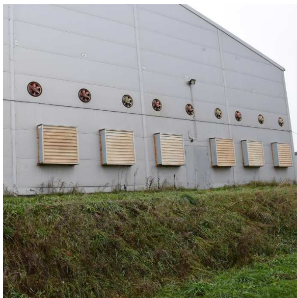
2.12.2. attēls. Esošās dējējvistu mītnes ventilācijas izvadi gala sienā
