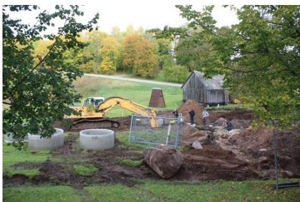
44. attēls. Pie pagasta pārvaldes ēkas notiek kanalizācijas sistēmas izbūve
