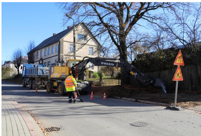
23. attēls. 2018. gadā uzsākta ielu pārbūve
