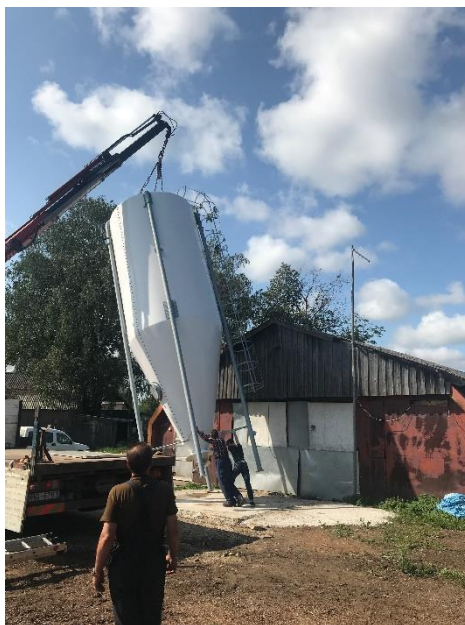
56. attēls. Granulu tvertnes (silosa) uzstādīšana Mālpē
