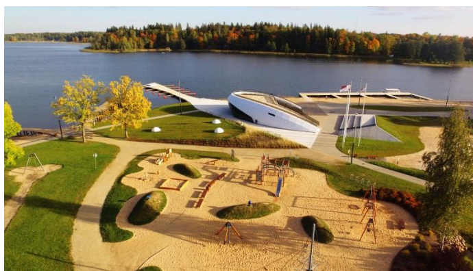
22. attēls. Pilssalas infrastruktūras izbūve (Alvita Grīvnieka foto)
