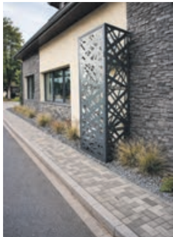
IEKĀRTA INTEGRĒTA ĒKAS FASĀDĒ
