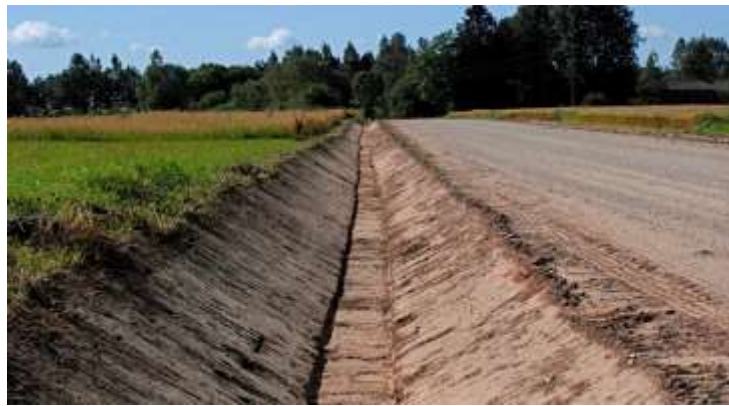
86. attēls. Remontdarbi autoceļā Pededze-Kalnapededze
