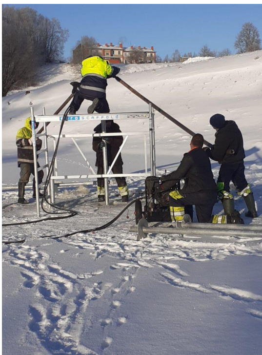
30. attēls. Laipas izbūve Dzērvē ezerā
